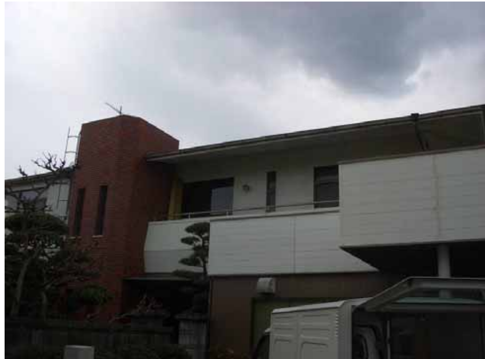
Before (改修前) - 外壁改修 -
