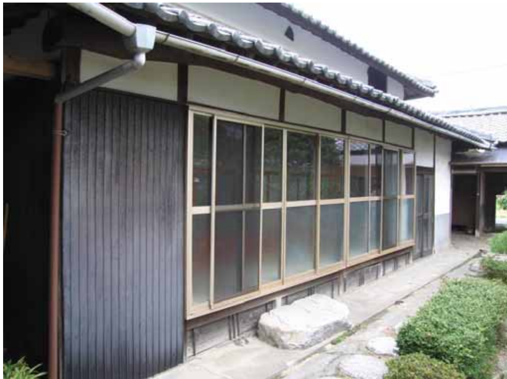
Before (改修前) - 外壁 -
